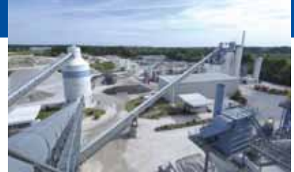
Alimentation entièrement automatique des centrales à béton et des centrales à asphalte
